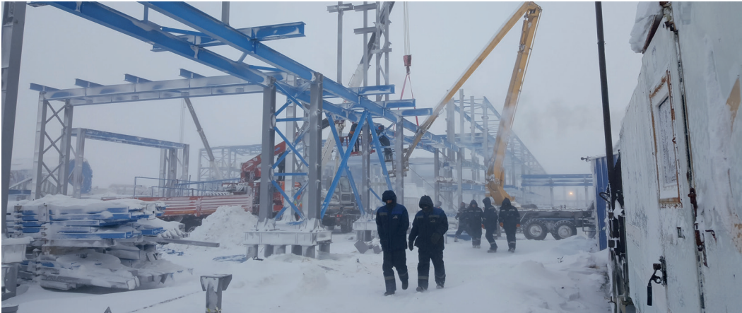
На монтаже ДКС
