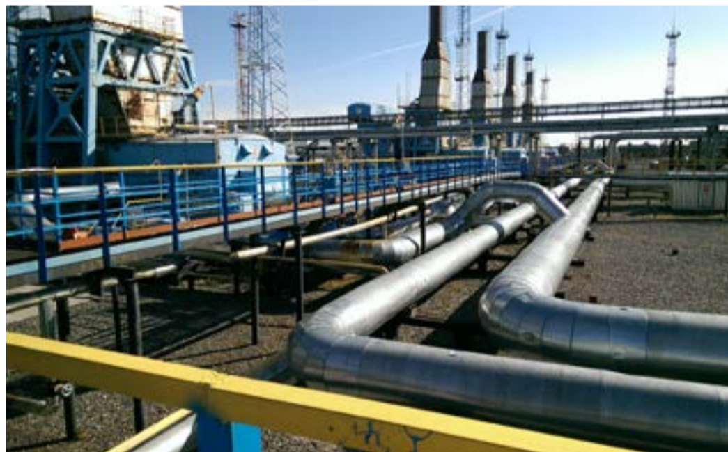
ДКС Губкинское месторождения
