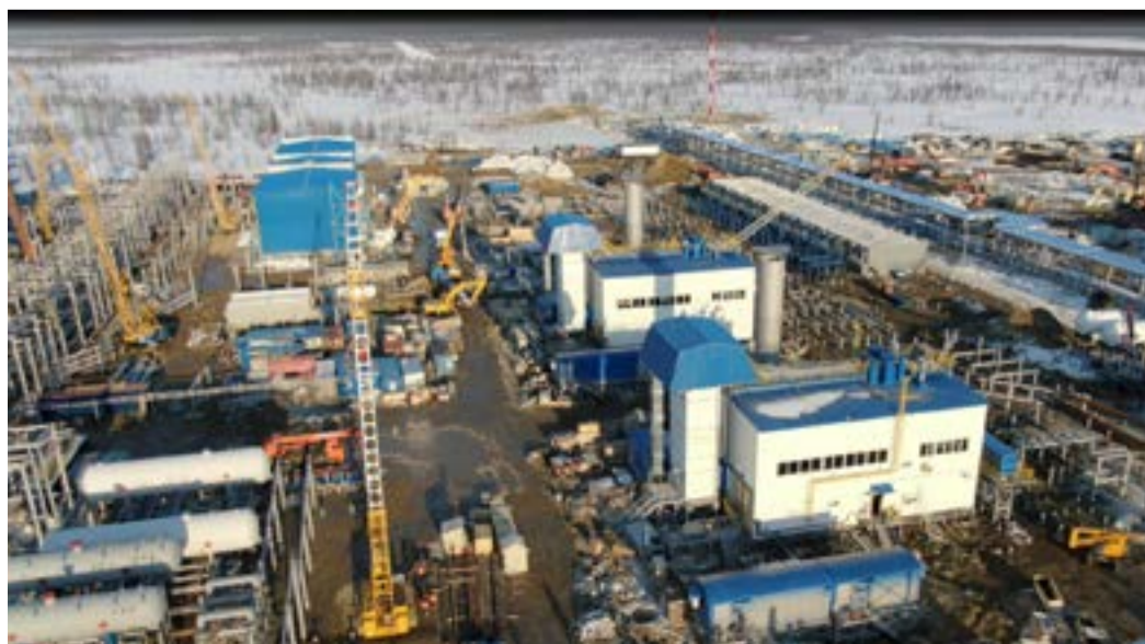
ДКС Северо-Русского месторождения
