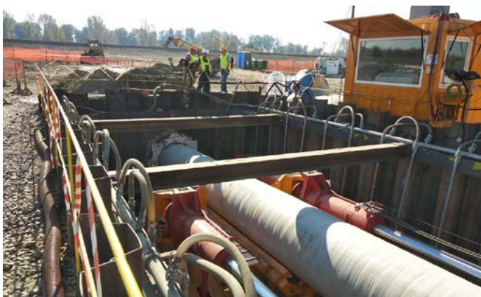
Строительство перехода газопровода
