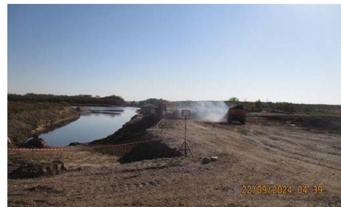
Строительство подводного перехода через реку Бурея
